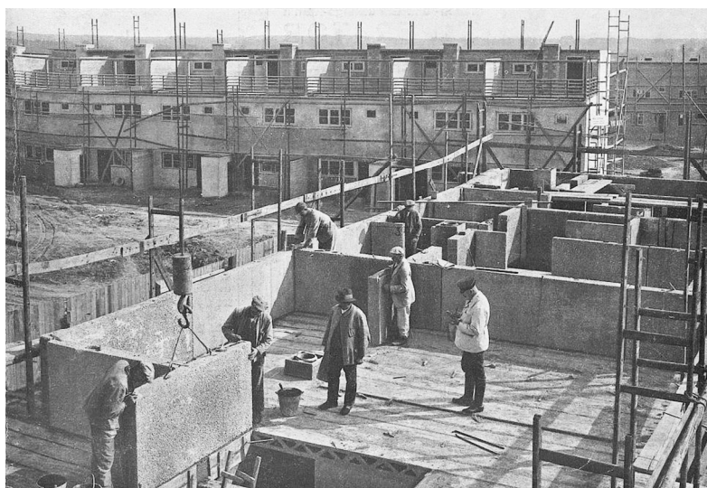
Figure 3. Ernst May: “Frankfurter Montageverfahren” (‘Frankfurt assembly method’; Photo from Das Neue Frankfurt 1926/1927, p. 33).
