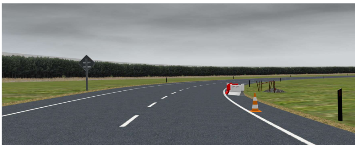
Figura 2.31. Primo ostacolo puntuale, lavori in corso che occupano la banchina, Tratto 2, visuale passeggero
